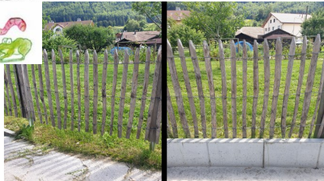
Un muret en béton (à droite) peut rendre une barrière infranchissable pour la petite faune
